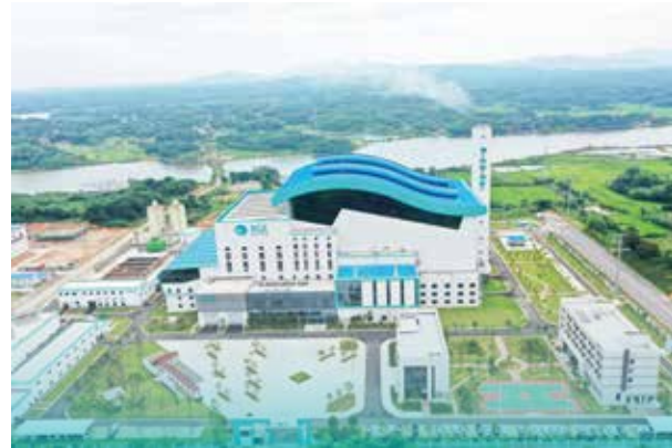
岳阳生活垃圾焚烧发电项目
