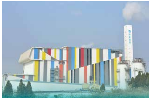
荆门生活垃圾焚烧发电项目
